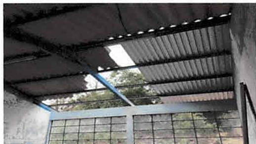
Foto1: Mejoramiento de Estructura portante y sustitución de lámina.
